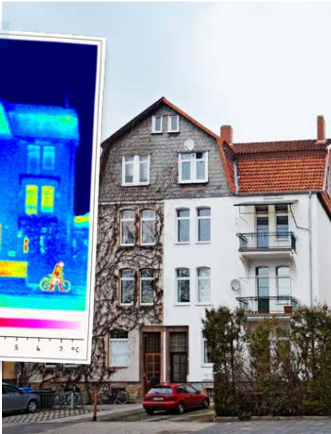
In der Thermografie gut zu erkennen: Bauteile mit einem hohen U-Wert (warme Farben) leiten viel Wärme nach draußen. Bauteile mit einem niedrigen U-Wert (kalte Farben) halten die Wärme im Haus.
